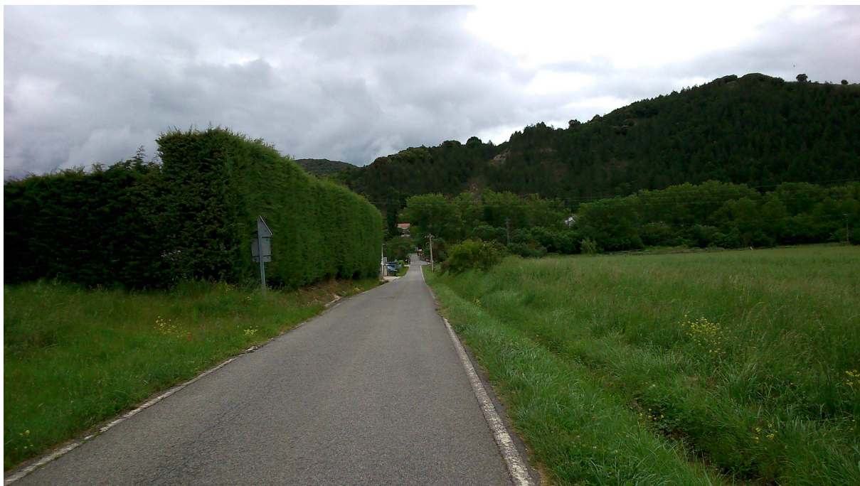
PK 0+280 SENTIDO INVERSO ▼
